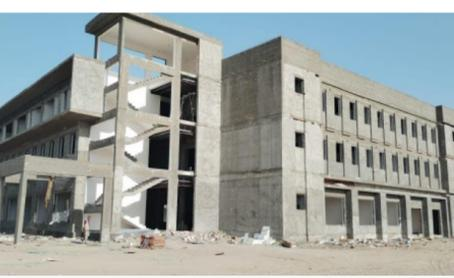
أعمال البياض للجدران بالخمر والاستمرار بأعمال التسليح للقبابوات الكهربائية لمأخذ القوى والتيار الخفيف والمباشرة بأعمال التنظيف للأطارات الحديدية للشبابيك والتهئية لأعمال تثبيت شبابيك الأنبيوم، وإجاز أعمال صب الكورت الوسطي وغرفة الكهرباء، وتكون البناية من ثلاثة طوابق
