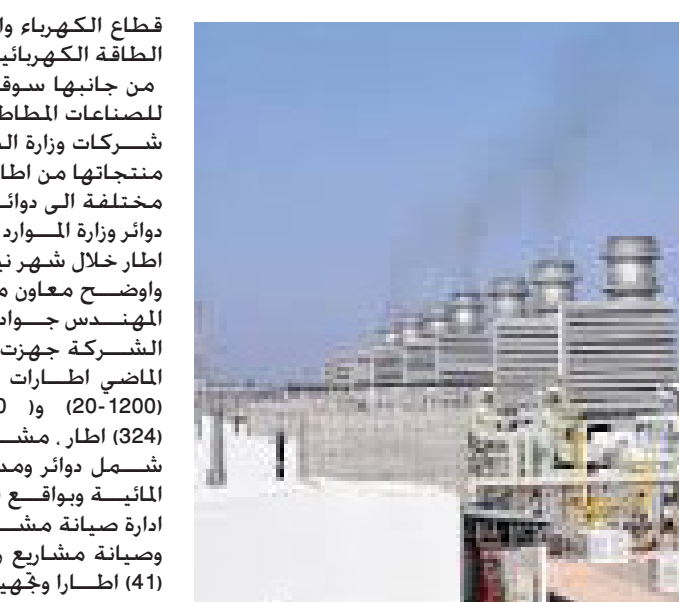
تشغيل محولة قدرة في محطة كهرباء الديوانية
