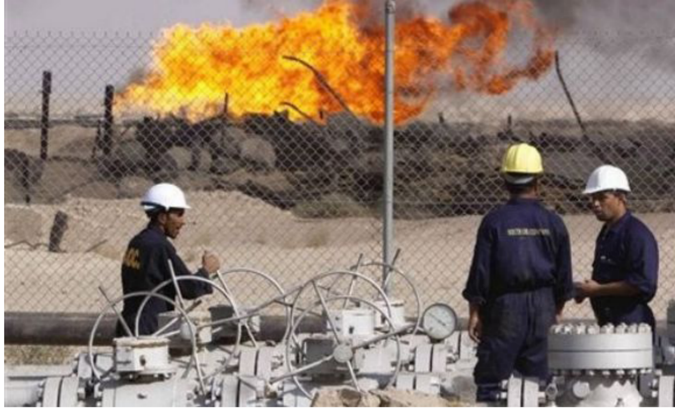
حقول النفط جنوبي البلاد
