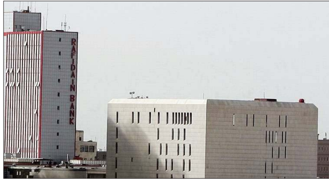
مبنى البنك المركزي
