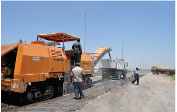
جانب من أعمال الصيانة
