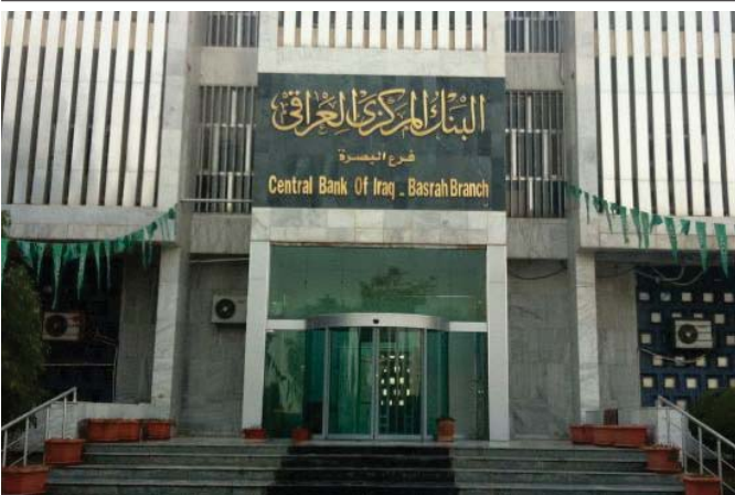
مبنى البنك المركزي فرع البصرة
